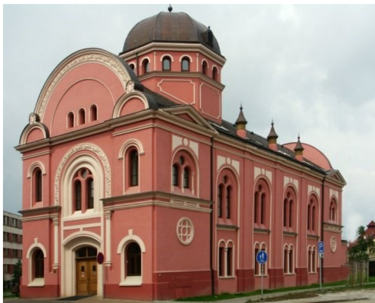
Obr. 1 Bývalá židovská synagoga – budova Knihovny BBB. Zdroj: autorka příspěvku
