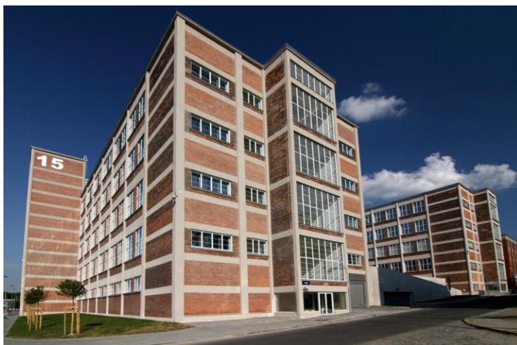
Obř. 1 Pohled na budovy 15 a 14 ze severozápadu. Zdroj: Dalibor Novotný
