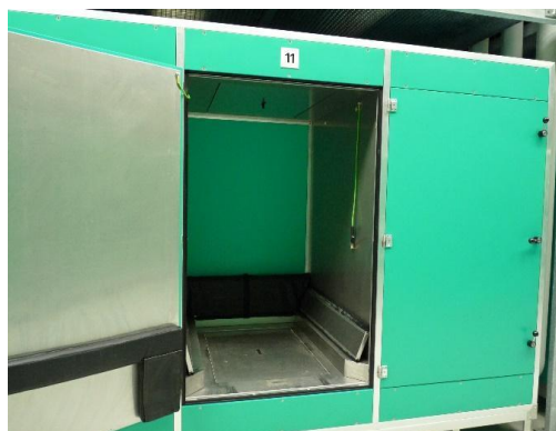
Obr. 7 Kondičnační komora Zdroj: autoři příspěvku
