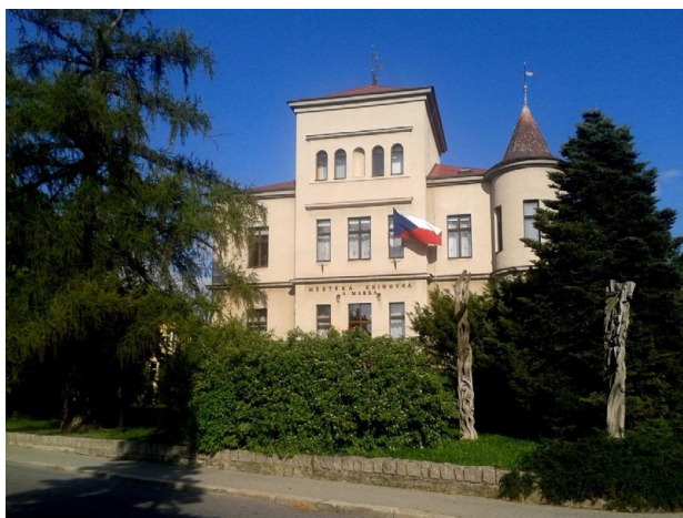
Obr. 1 Současná hlavní budova městské knihovny v Turnově v Jeronýmově ulici. Foto: archiv autora
