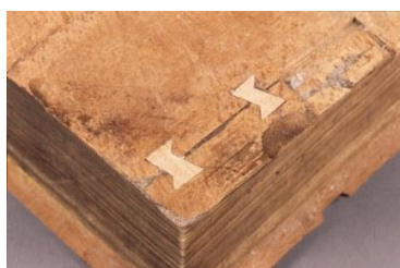
Přichycení dřevěné části pomocí spojovacích prvků ve tvaru motýlků
